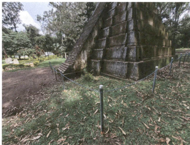
Foto 15, 16, 17, 18 y 19. Mantenimientos descritos anteriormente.
