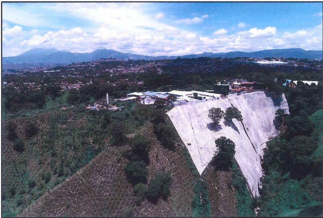
**Fotografía12: IMAGEN PANORAMICA MURO SOIL NAILING Y REFORESTACION**
