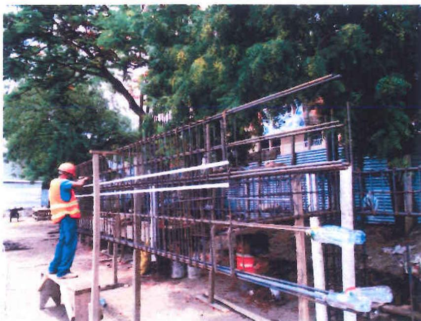
**Maqueta de armadura de viga cenefa para todos los edificios**
