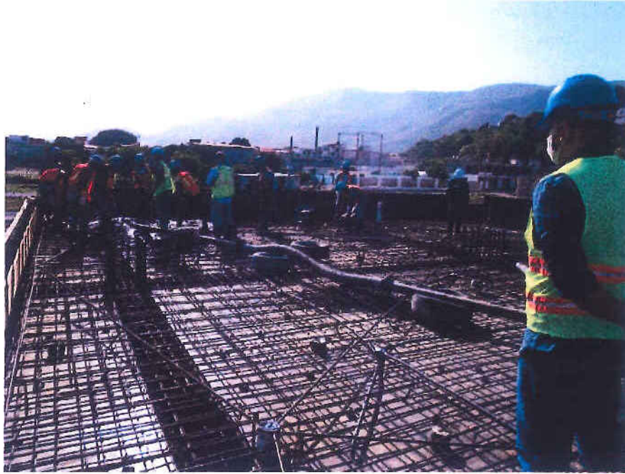
Inicio de fundición, edificio de baños
