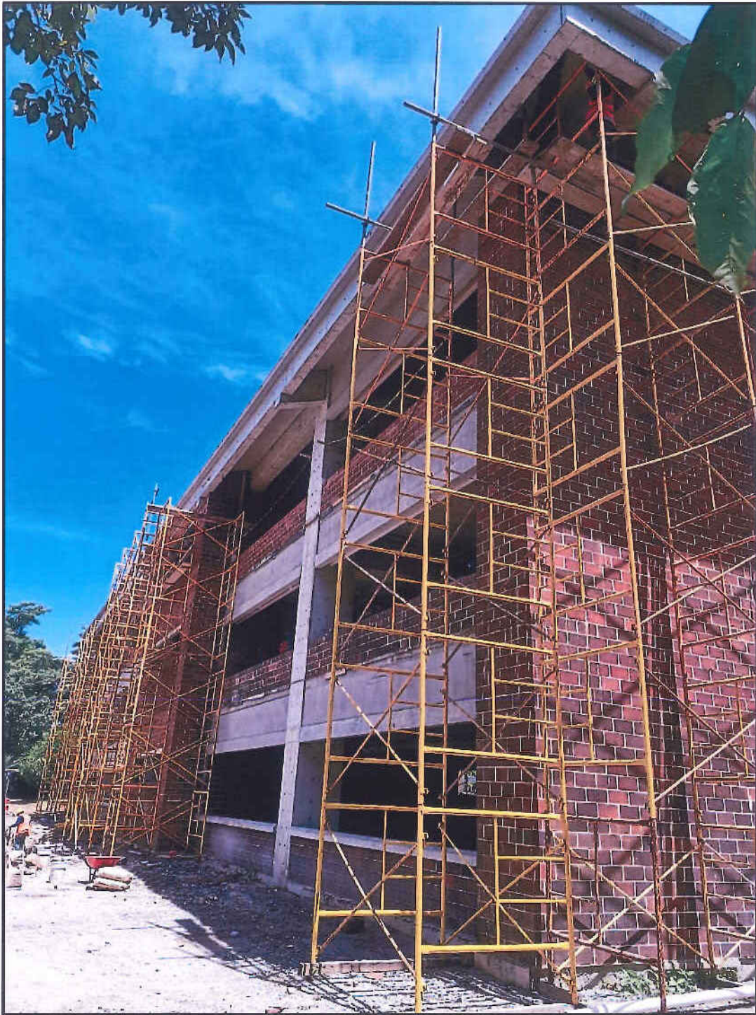
Fotografía 3: IMAGEN FACHADA POSTERIOR
