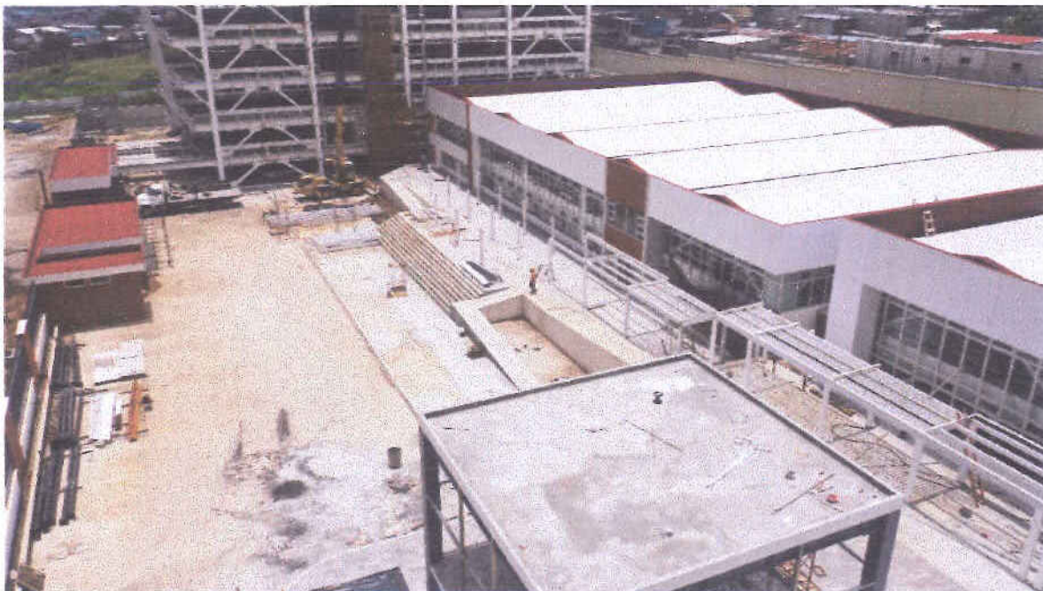
Vista lateral general del proyecto.
