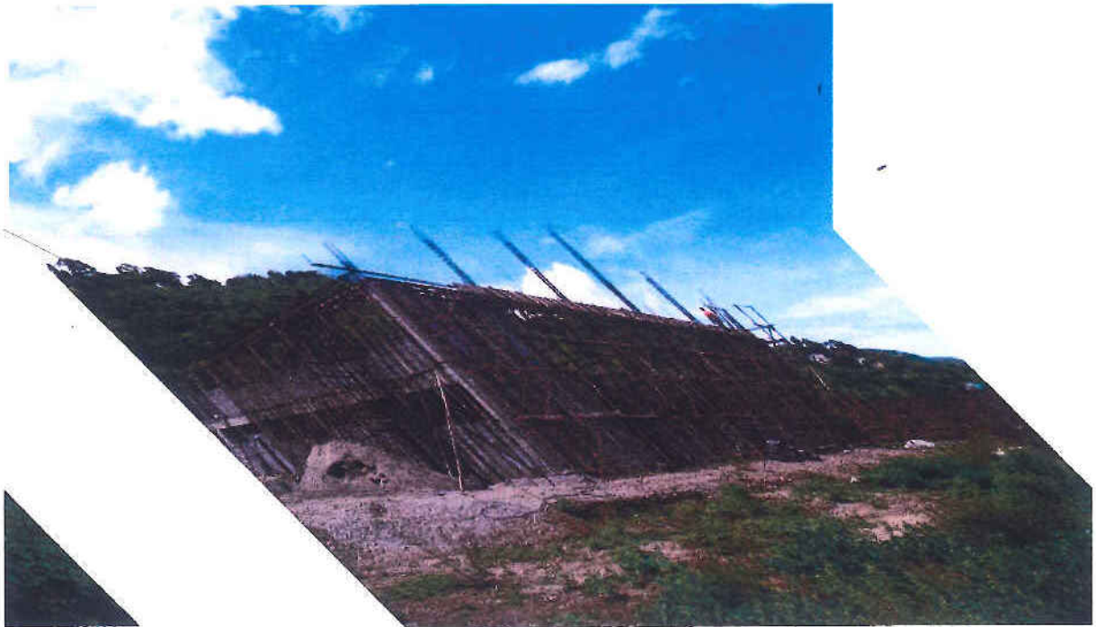
Armadura de vigas en edificio de talleres
