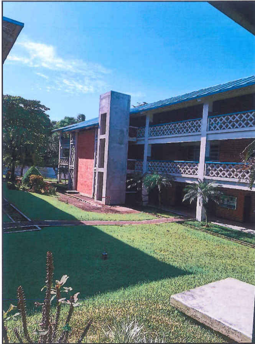
Fotografía 7: IMAGEN MODULO DE ELEVADOR
