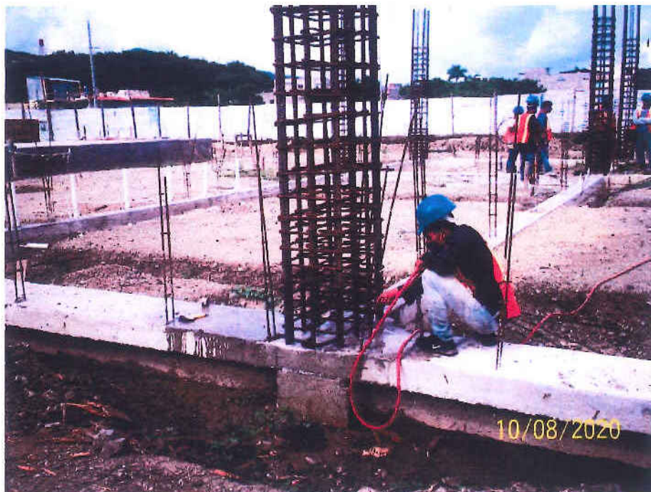
Preparación de columnas para edificio de baños
