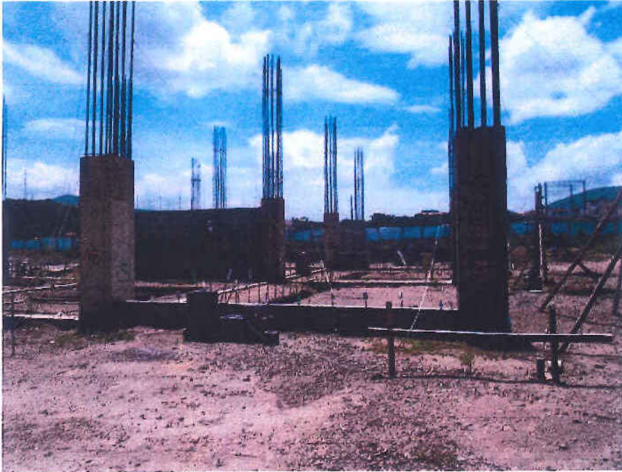
Columnas de edificio administrativo
