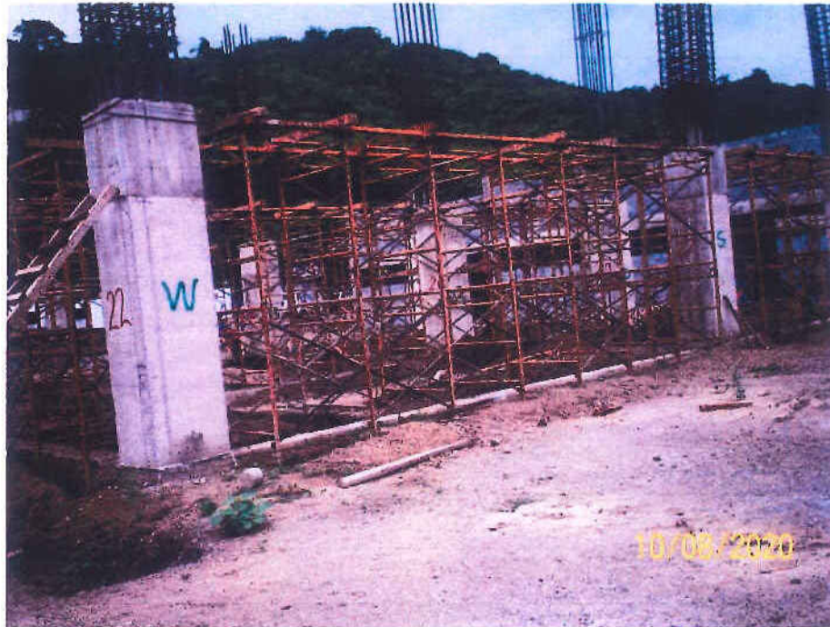
Entarimado para armadura en edificio administrativo
