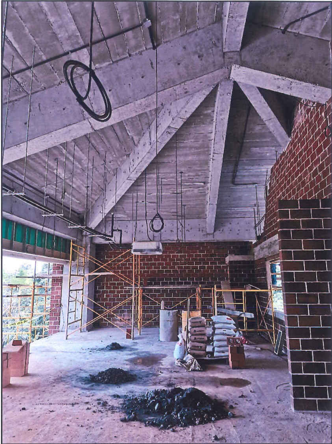
Fotografía 6: IMAGEN INTERIOR DE SALONES
