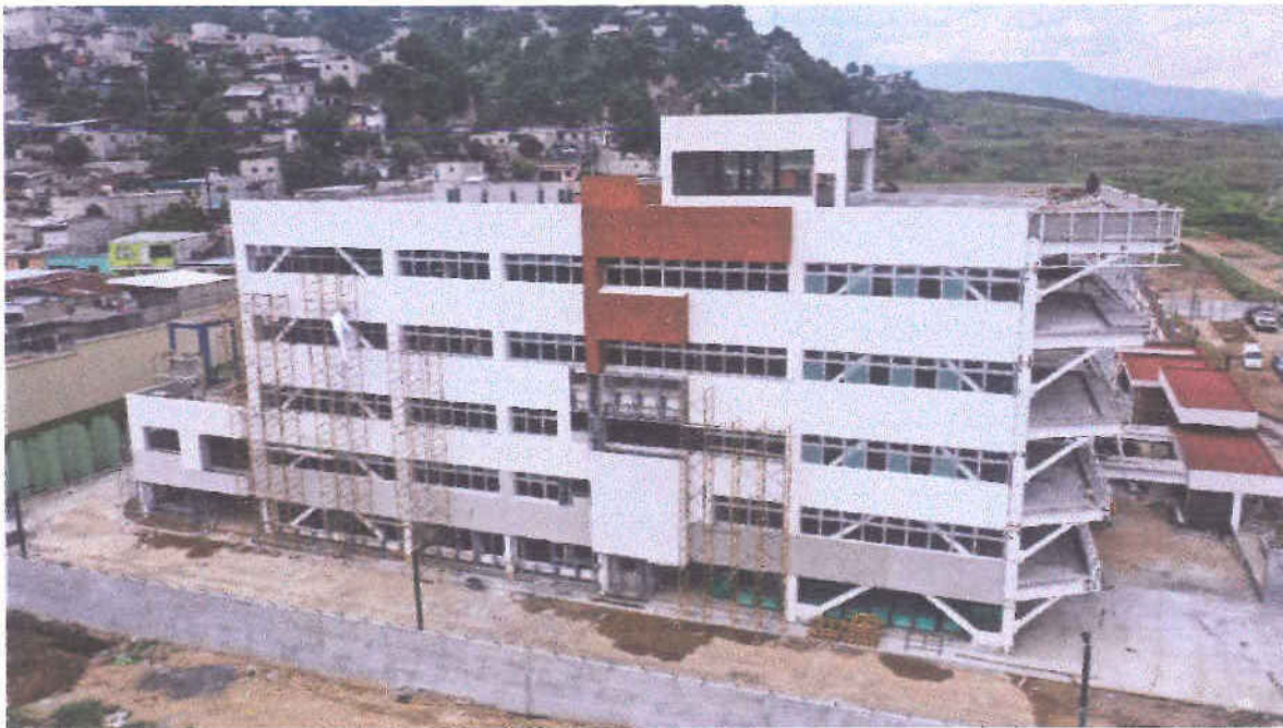
Vista lateral del Edificio Administrativo.
