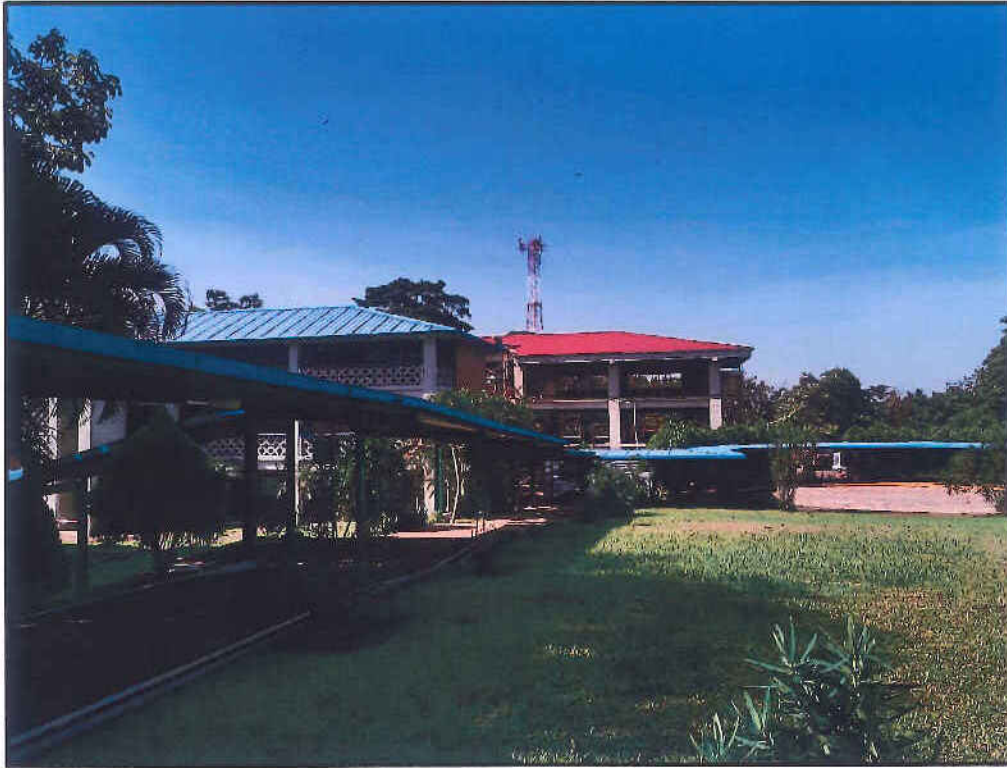
Fotografia 1: IMAGEN VISTA PANORAMICA
