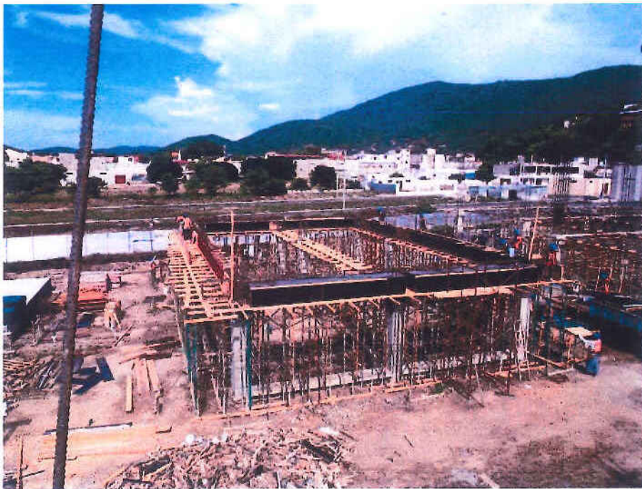
Formaleta para armadura en edificio de baños
