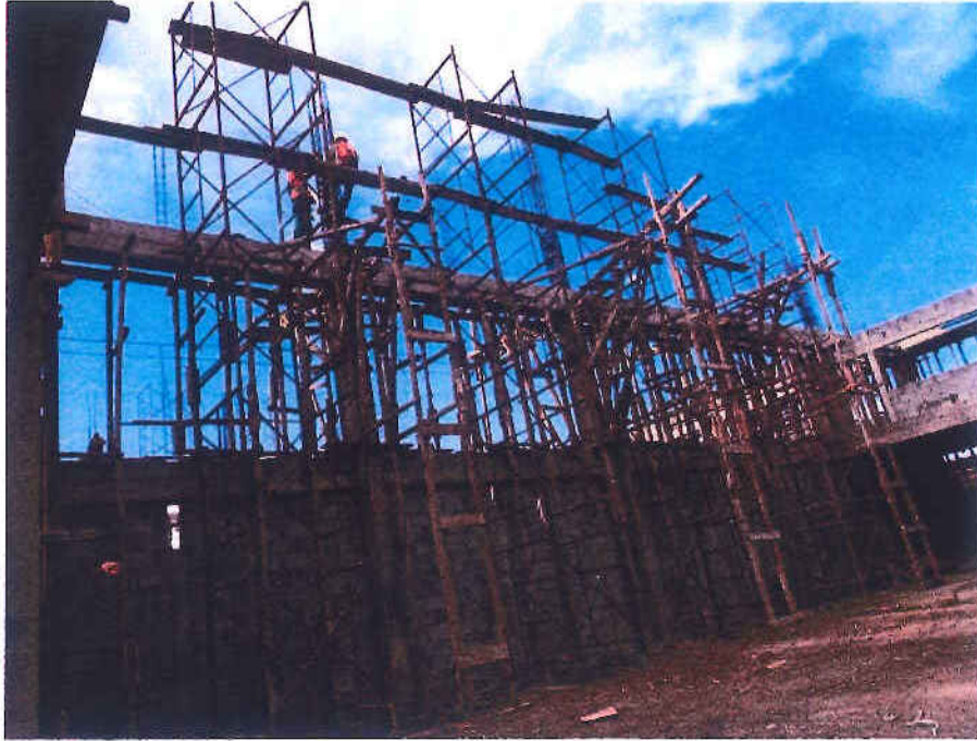
Preparación de columnas para edificio de talleres
