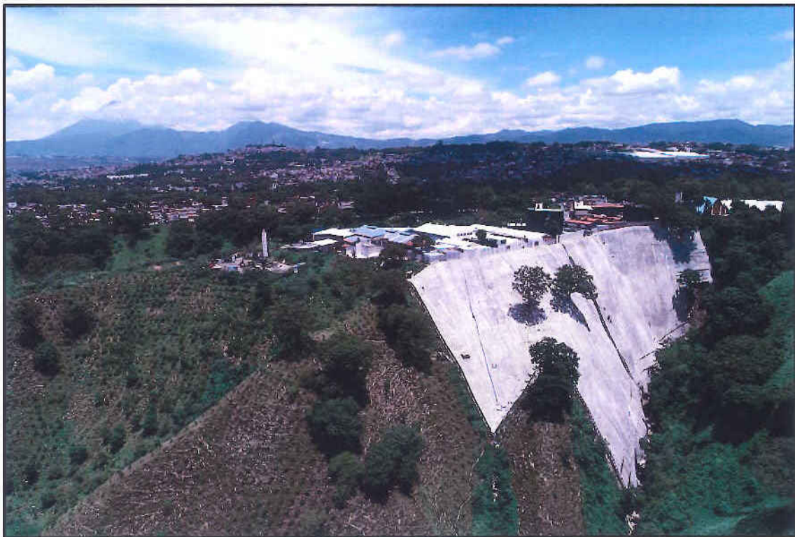
Fotografía12: IMAGEN PANORAMICA MURO SOIL NAILING Y REFORESTACION
