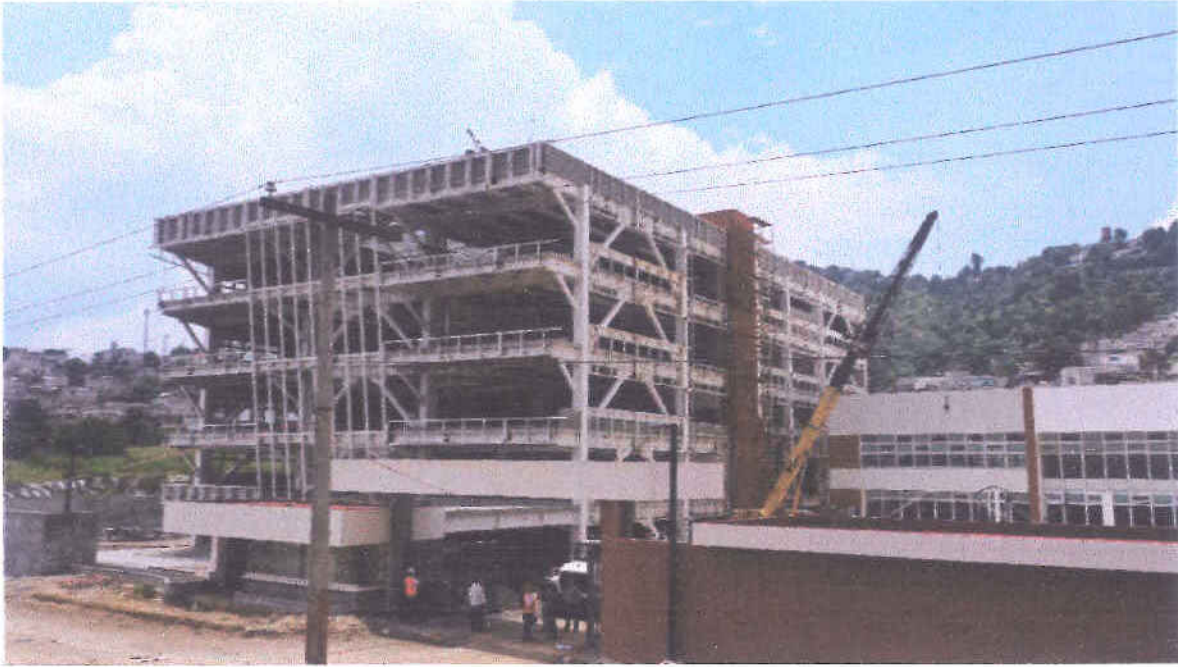
Vista Frontal del Edificio Administrativo.
