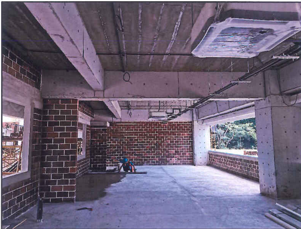
Fotografía 5: IMAGEN INTERIOR DE SALONES
