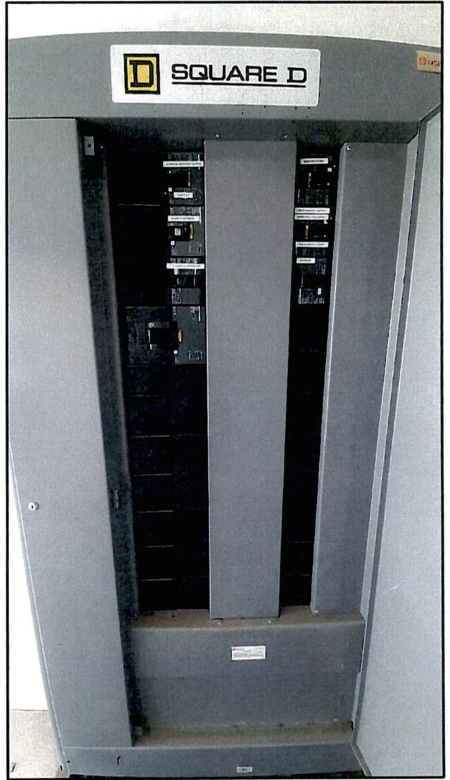
FOTOGRAFÍA 6: Breaker en Tablero Principal de 3 x 250 amperios 120/208V Trifásico
