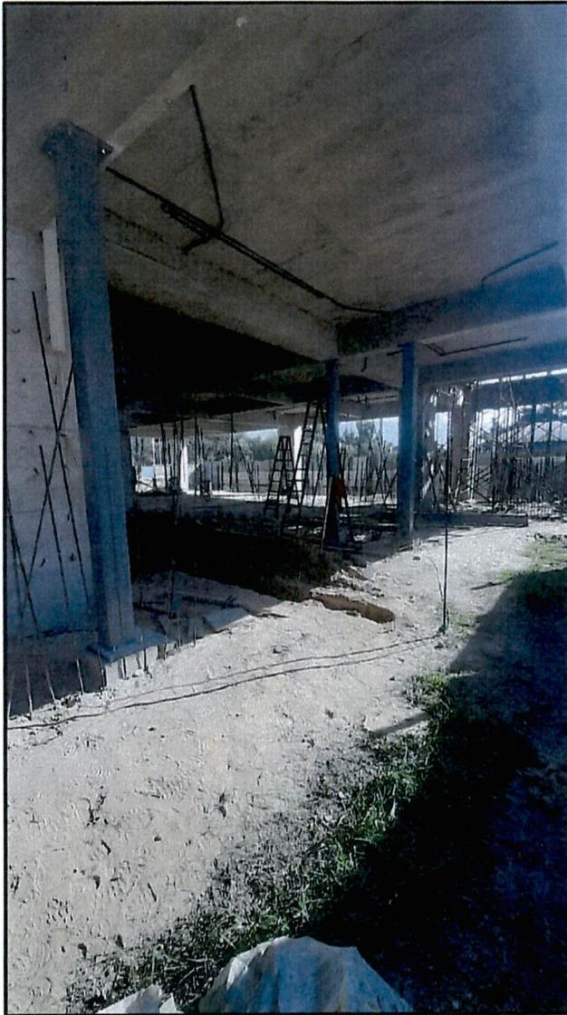
FOTOGRAFÍA 5: Colocación de columnas metálicas interiores
