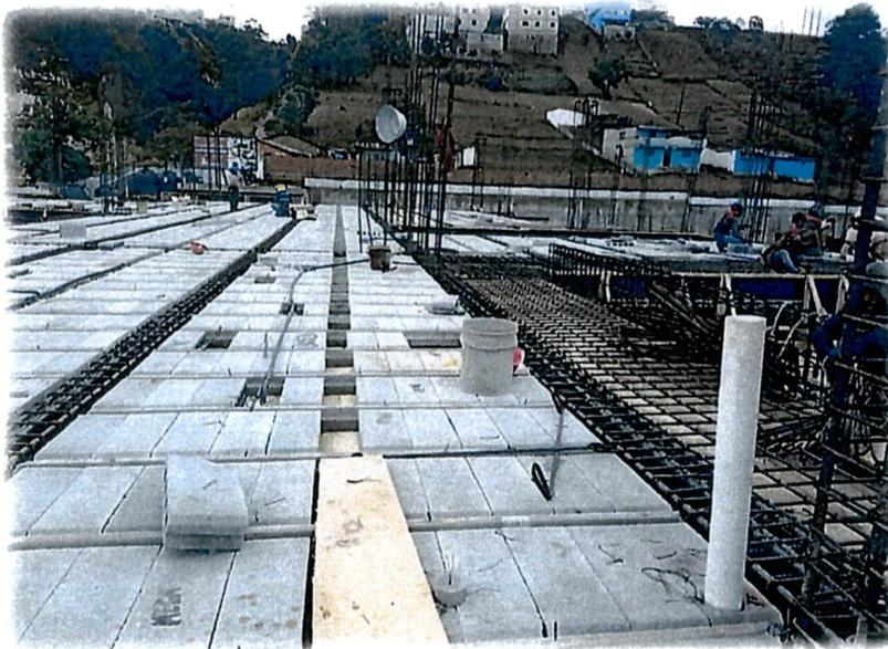
**Instalación de Losa: Vigueta y bovedilla.**
