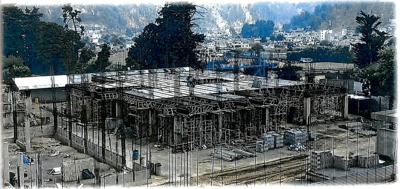
**Montaje de losa nivel 1 de Edificio Administrativo. Técnica: Vigüeta y bovedilla.**
