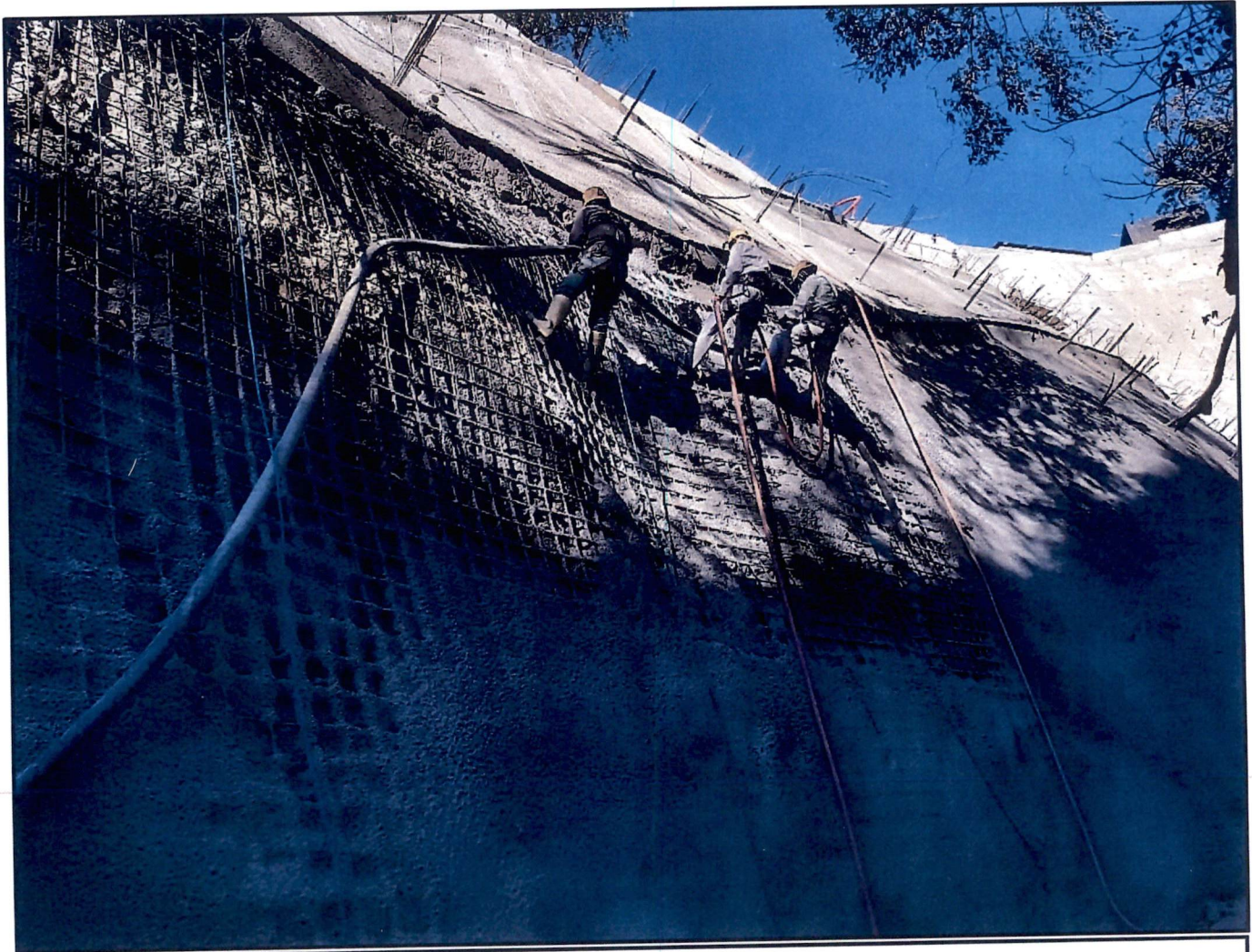
FOTOGRAFIA 14: Control de erosión en cuenca
