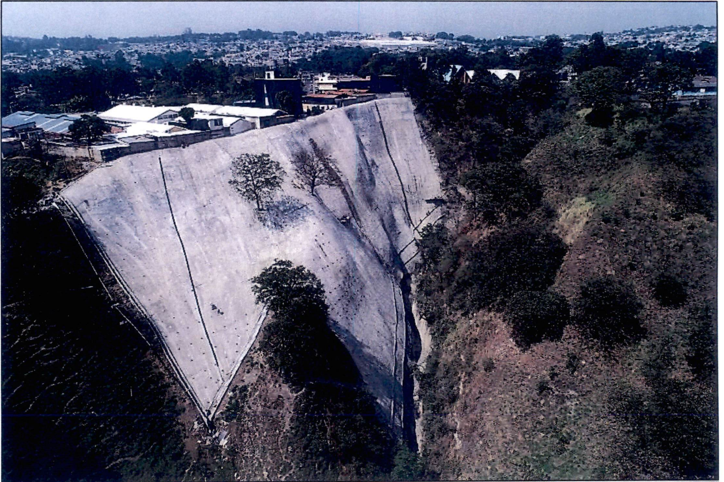
Fotografía 8: Visual aérea de muro soil nailing
