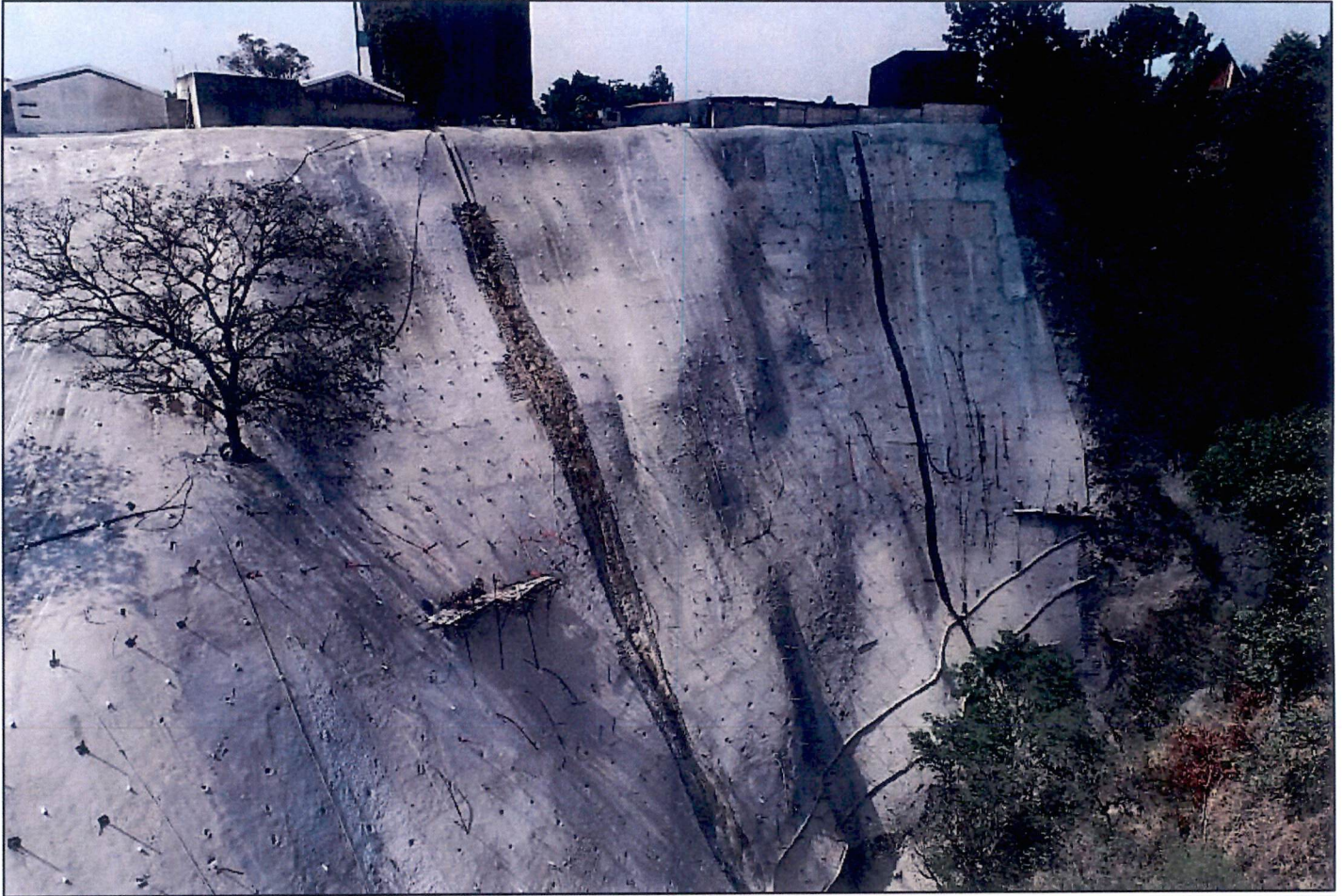
Fotografía 7: Visual aérea de muro soil nailing
