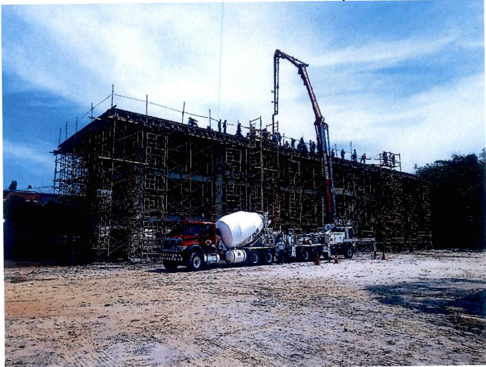
Fundición la losa del techo del edificio Torre de Aulas 3.
