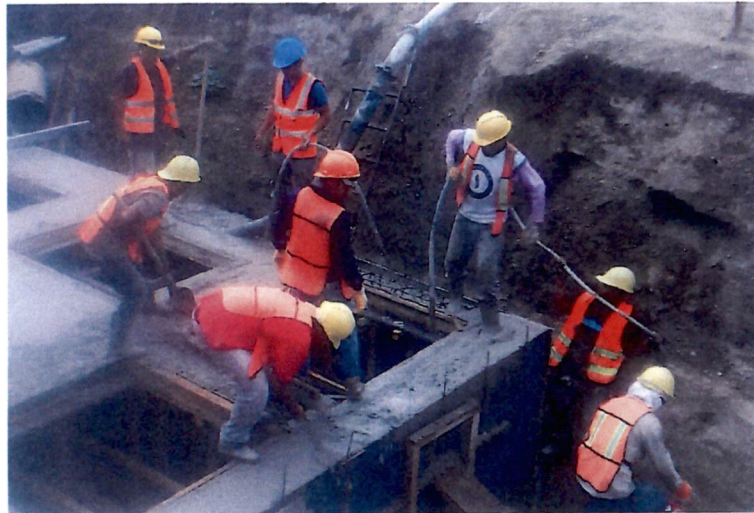
Fundición de losa en planta de tratamiento
