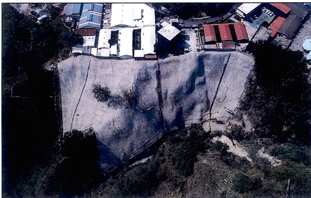
Fotografía 7: Visual aérea de muro soil nailing
