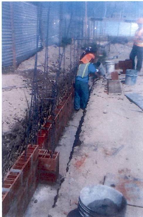
Cimentación de muro perimetral
