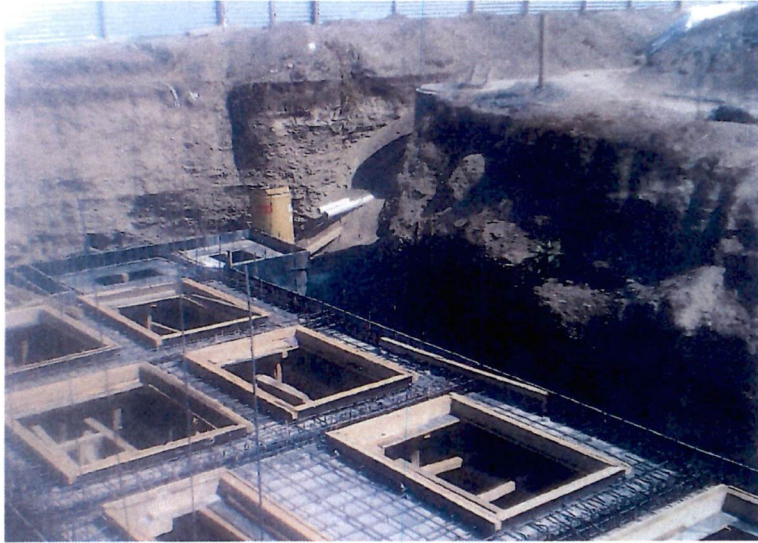
Armaduría de losa de planta de tratamiento
