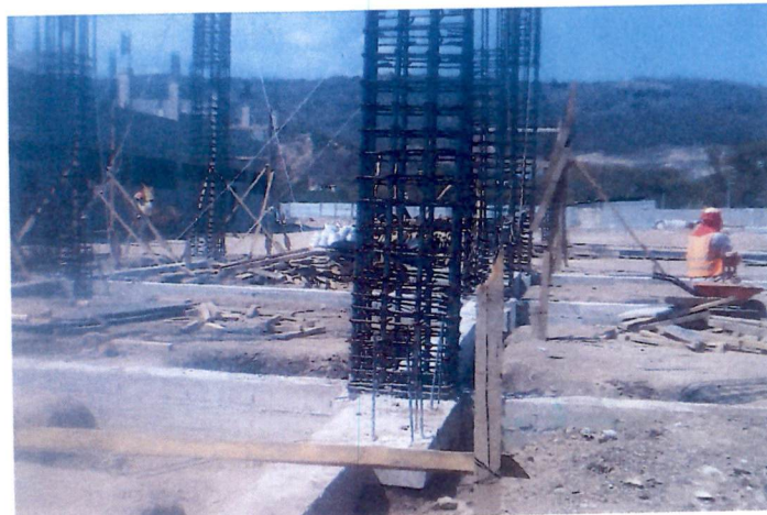
Vigas de amarre fundidas en el edificio de Administración
