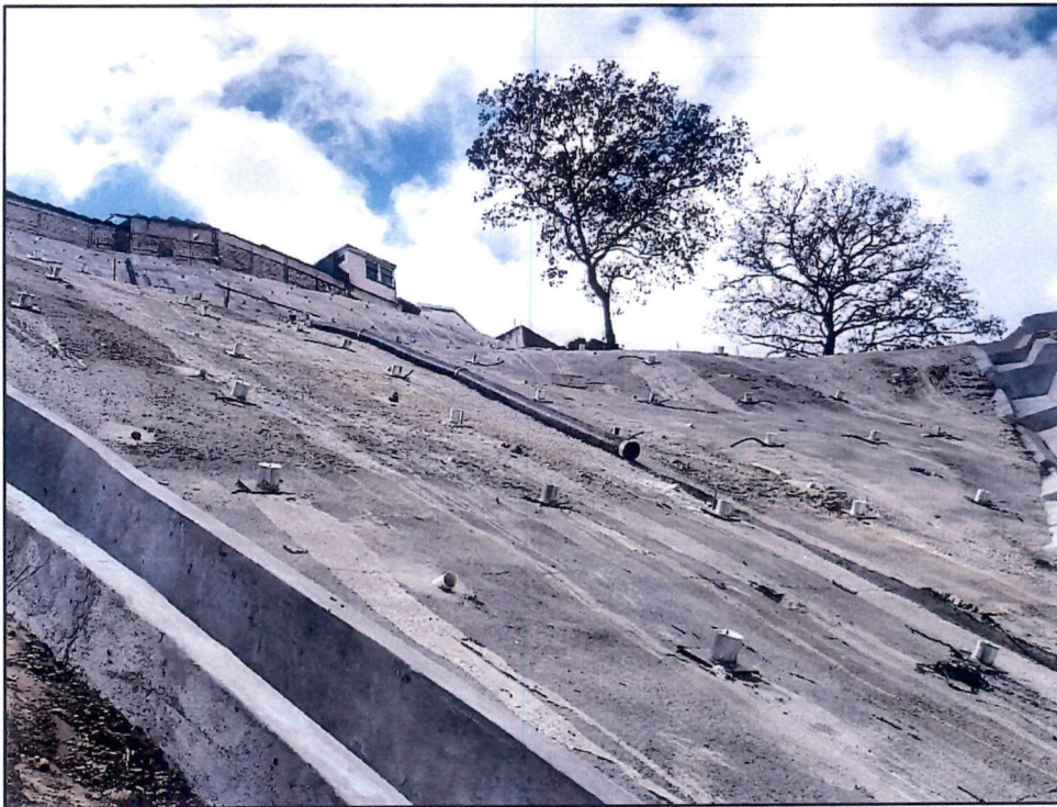
Fotografía 5: visual de disipador y cuneta en muro
