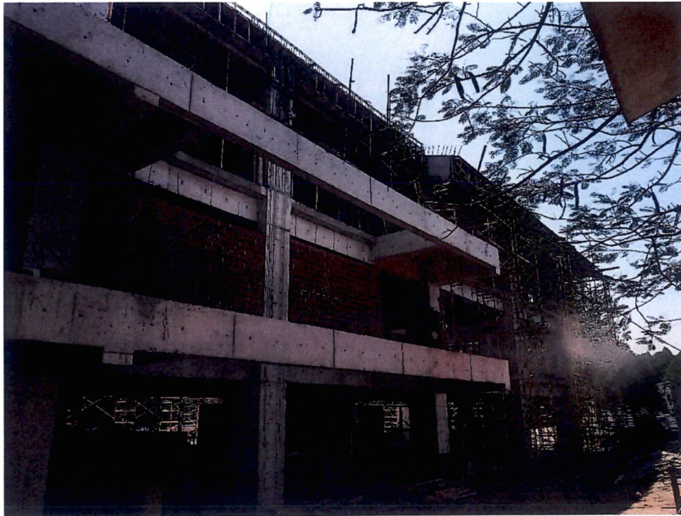
Área de Modulo de Gradas del edificio Torre de Aulas 3.
