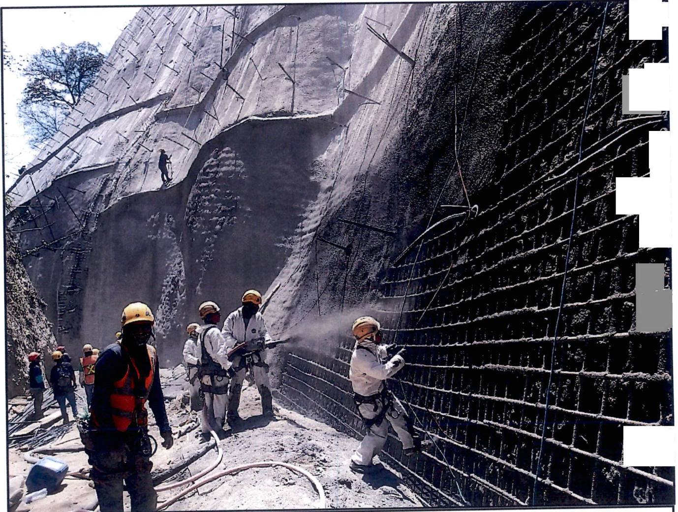
FOTOGRAFIA 11: Lanzado de sabieta en control de erosión del parte inferior del muro en cuenca
