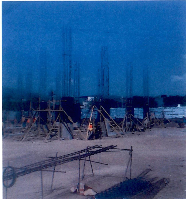
Columnas del primer nivel fundidas en edificio Administración
