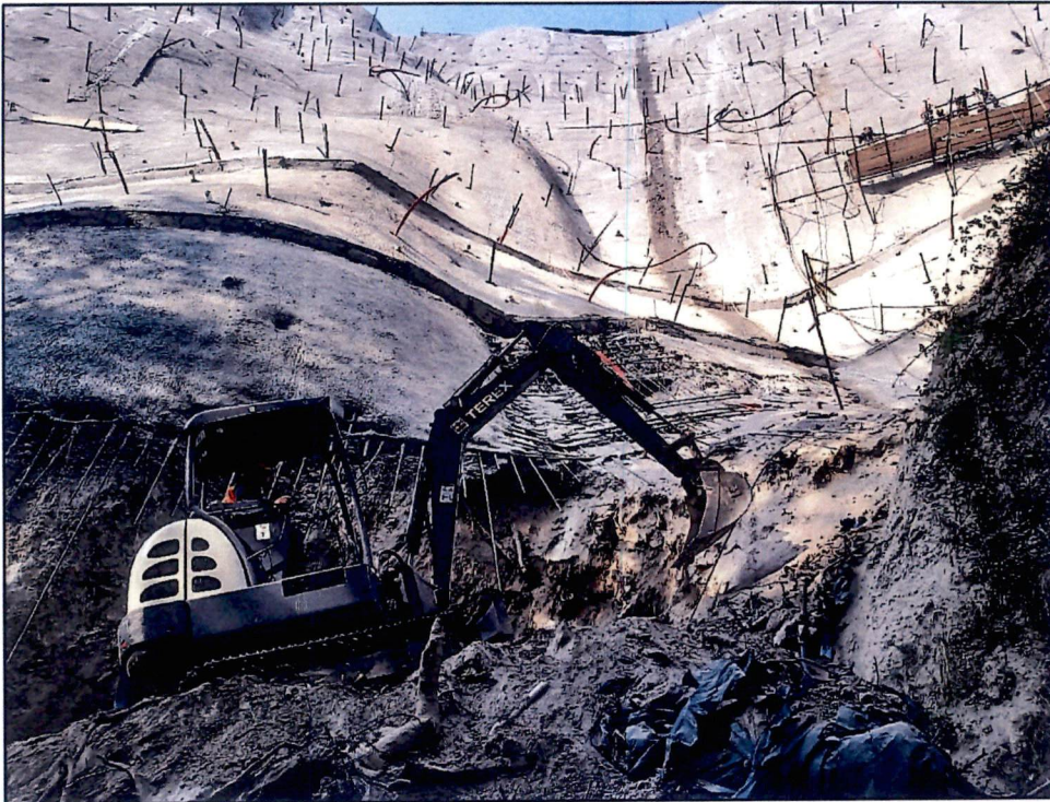
Fotografía 2: Limpieza, nivelación y extracción en cuenca
