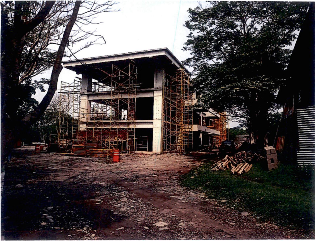
Levantado de muro exterior de ladrillo visto
