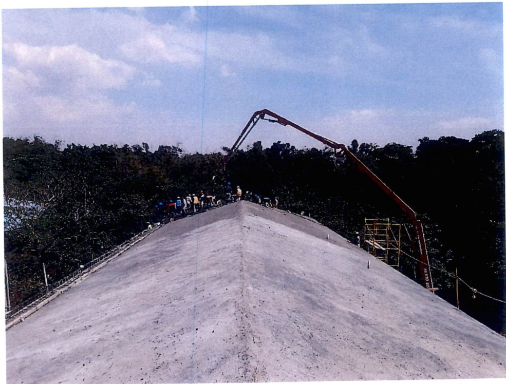
Fundición de la losa del techo de edificio Torre de Aulas 3.
