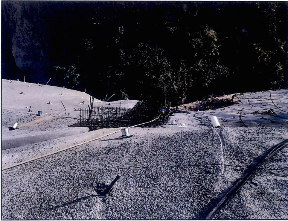
Fotografía 4: Colocación de estructura de disipador
