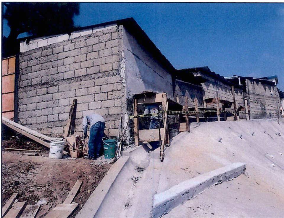
Fotografía 6: fundición de cuneta corona y colocación de andamios para acabado
