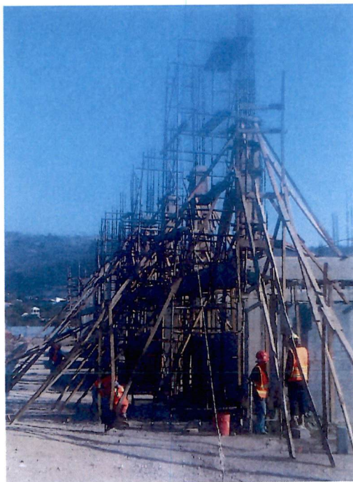
Formateado de columnas en taller de Electricidad
