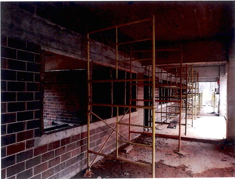
levantado de tabiques de ladrillo visto
